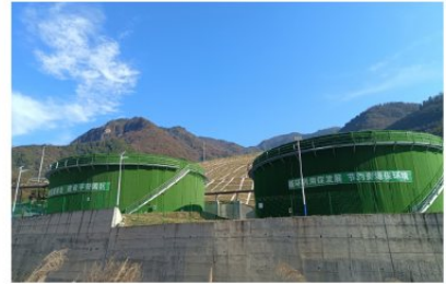
화재 비상용 물탱크 용량: φ27m*2, φ31m*2 φ12m*1, φ10m*3
