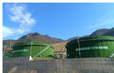
四川省漢源・緊急消防用水タンク 8基 φ27 m×2、φ31 m×2、φ12 m×1、φ10 m×3
