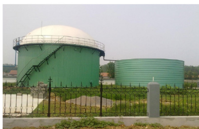
伊利乳業・成都邛崃 牛ふん尿処理 タンク上設置型 容量：250 m 3
