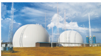
蒙牛・宝鶏 乳牛ふん尿処理 ガスホルダー容量：20,000 m 3 × 2基
