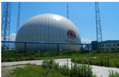
2012年 陝西省楊凌示範区 現代牧業・乳牛2万頭バイオガス発電 容量：20,000 m 3
