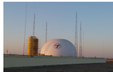
2014年 山東省済南市商河県 現代牧業・乳牛2万頭バイオガス発電 容量：20,000 m 3
