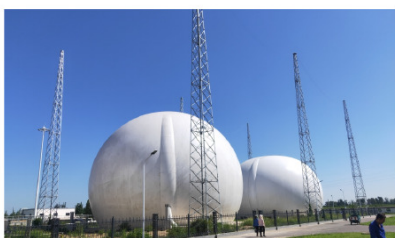
蒙牛・塞北バイオガス貯留 ガスホルダー容量：20,000 m 3 × 2基
