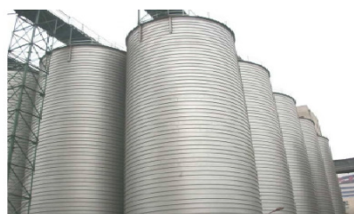
中儲糧・新津プロジェクト 容量：2,000 m 3
