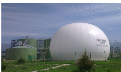
北京・延慶 德青源 鶏ふん処理プロジェクト 容量：2,500 m 3
