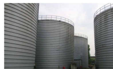
維爾利・蘇州相城／国家石油備蓄基地 成都白家プロジェクト 外鋼板・内膜式 2,000 m 3
