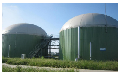
河北・双鶴プロジェクト タンク上設置型二重膜式 1,500 m 3 × 2基
