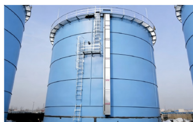
維爾利・蘇州相城 外鋼板・内膜式 2,000 m 3 × 1基
