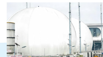
五糧液 ガスホルダー容量：5,000 m 3 × 2基
