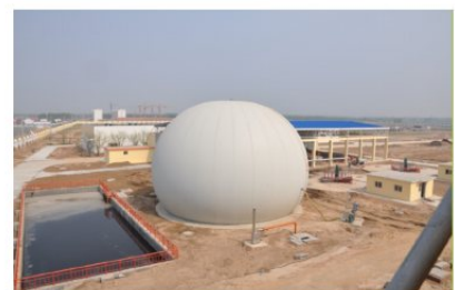
Shandong-Biogas untuk Tenaga ListrikGenerasi Volume: 3000m 3
