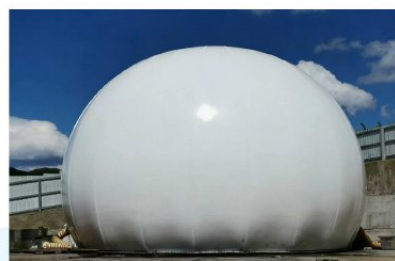
Penyimpan gas batubara fleksibel Sichuan Volume: 1000m 3
