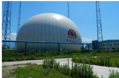
Proyek Pembangkit Listrik Biogas 2012 Volume:20000m 3
