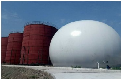
Qingdao Biomassa Teknik Energi Volume: 20000 m 3
