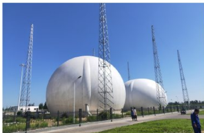
Toko Mengniu menyimpan biogas Volume: 20000 m 3 * 2
